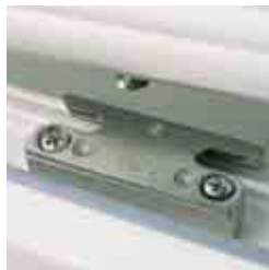
Système anti-décrochement* . Dans ce pack, les verrouillages sont tout autour de la fenêtre.
